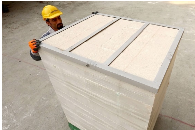
شکل ۱-۱۰- حمل پالت‌های انتقال بلوک‌های AAC
